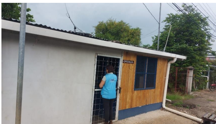
Foto: fachada de la oficina.
